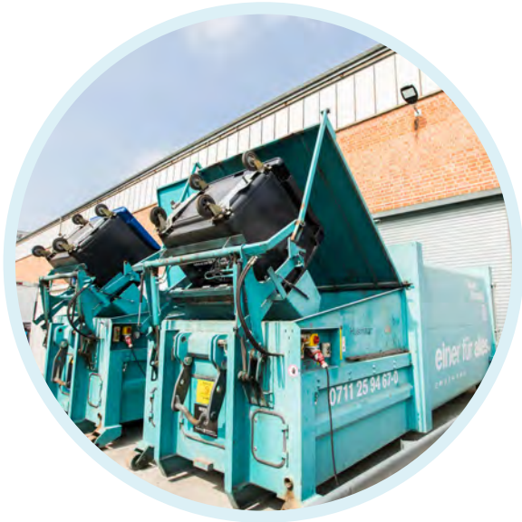
Aufbau Ihres Betriebs-Wertstoffhofs – zentrale Erfassung und Bündelung der Abfälle
