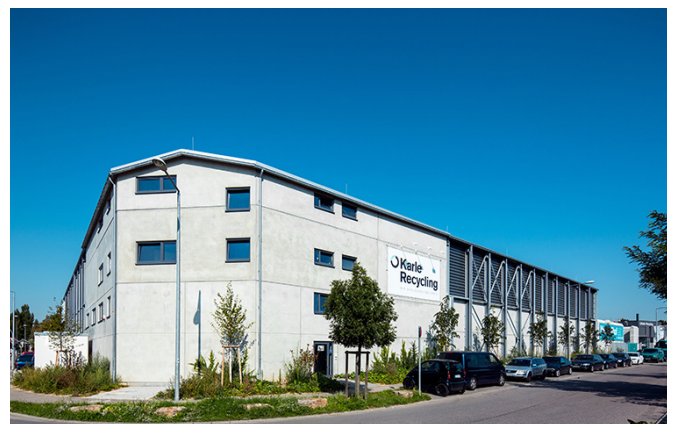
DIE ZUFAHRT ÜBER DIE FRIEDRICH-SCHOLER-STRASSE
