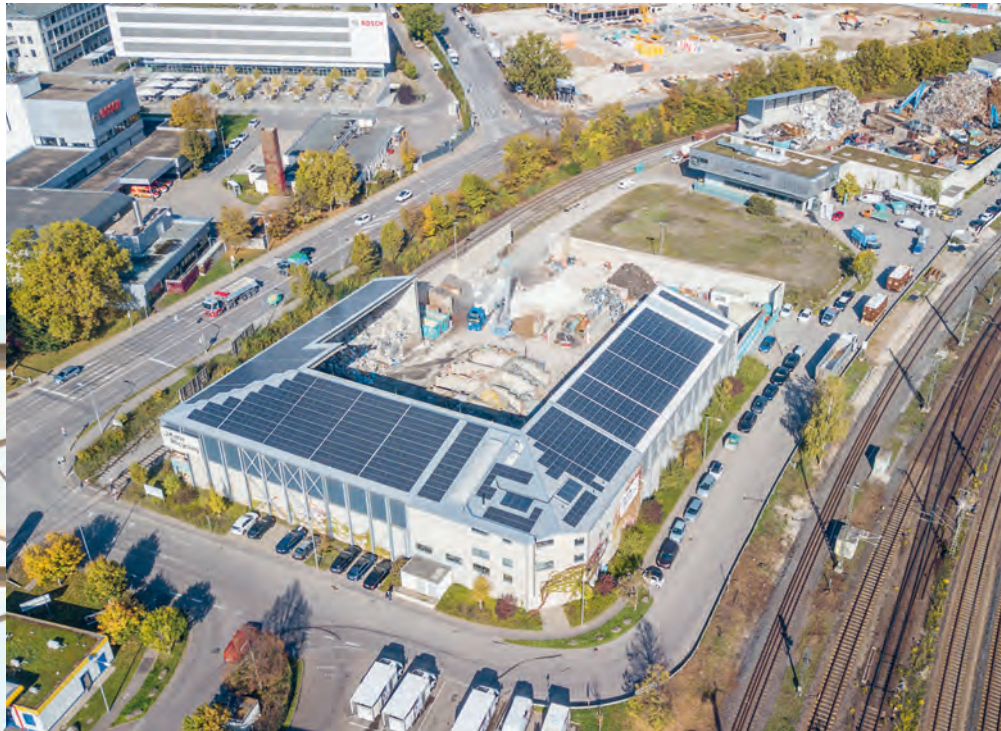
Die neue Photovoltaikanlage bei Karle Recycling in Stuttgart-Feuerbach.
