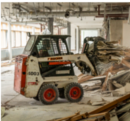
Kompaktlader bei der Entkernung.
