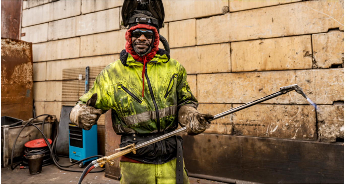
Henry Prelious mit seinem Arbeitsgerät, dem Schneidbrenner.
