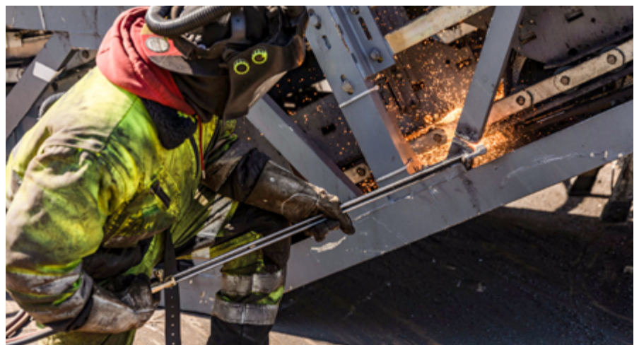
Henry Prelious beim Zerlegen einer Rolltreppe.
